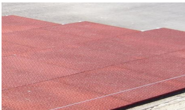
Verlegung der Platten entlang einer geraden Einfassung oder Kreidelinie
