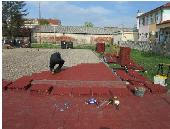
Richtige Verlegung im T-Verbund, falsche Verlegung im Schachbrettmuster
