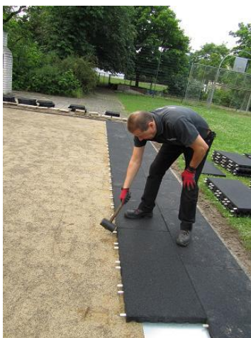
Schließen von Lücken mit einem Hammer
